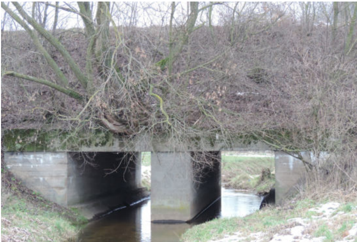
Przepust kolejowy pod Sędziwujami, przy budowie którego pracował Angelo Roffinella (fot. J. Strenkowski)
