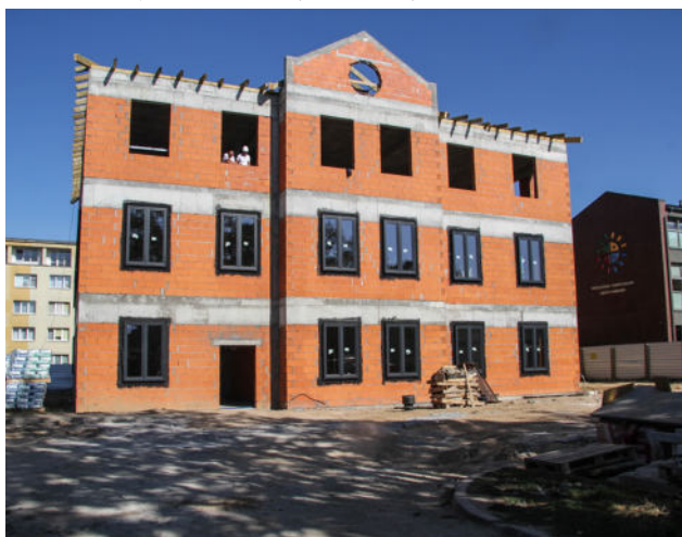
Budowa siedziby Urzędu Gminy Zambrów
